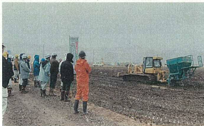
【研修状況：工事現場視察】
