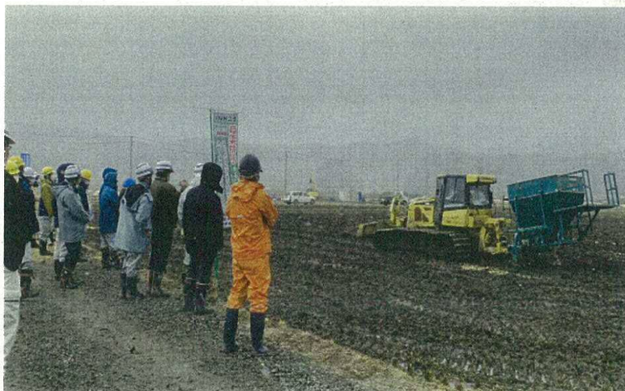
【研修状況：工事現場視察】
