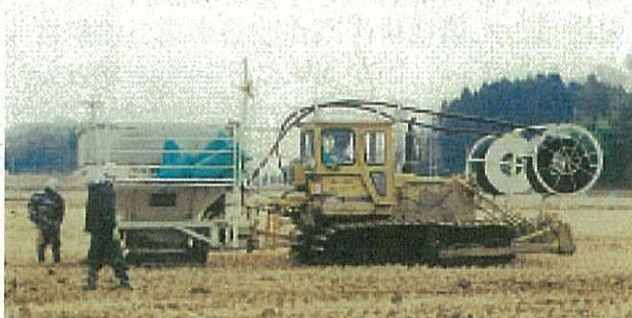
ドレーンレイヤー（公社保有）の暗渠排水工事
