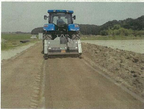
ストーンクラッシャーの石レキ除去工事
