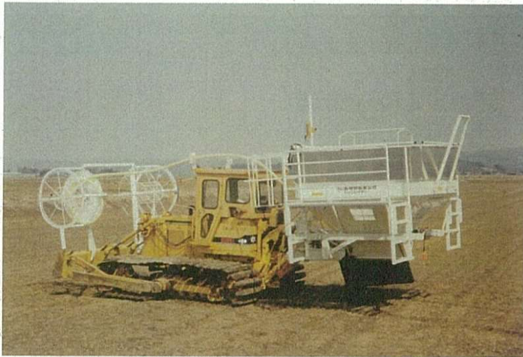
ドレンレイヤー（公社保有）による暗渠排水工事
